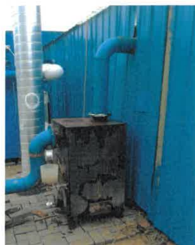
气化炉水浴除尘器
